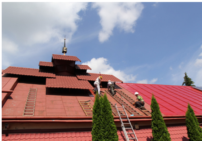
W lipcu i sierpniu br. pracownicy solidnie umyli, odczyścili i pomalowali dach na Katolickim Centrum Kultury.
